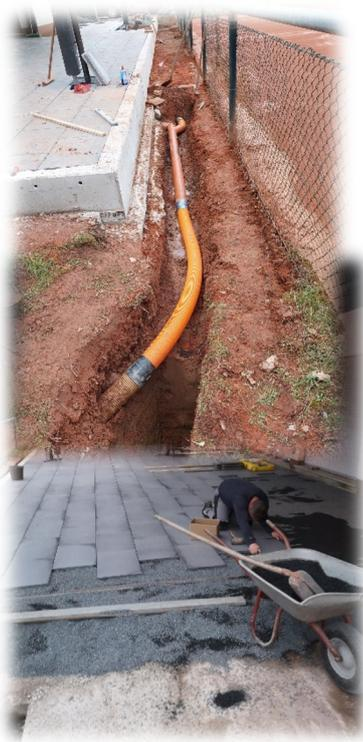
Ebenso wurden die Entwässerung der Terrasse und eine neue Drainage für die Regenfallrohre berücksichtigt.
