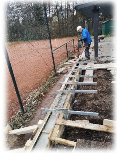
Mit dem Fundament und den einzelnen Mauerabschnitten, waren dann auch immer die Betonier Arbeiten verbunden. Nach jedem Mauerabschnitt musste ausgeschalt und das Schalmaterial zur Wiederverwendung entnagelt und gesäubert werden. Schon sehr aufwendig.....
