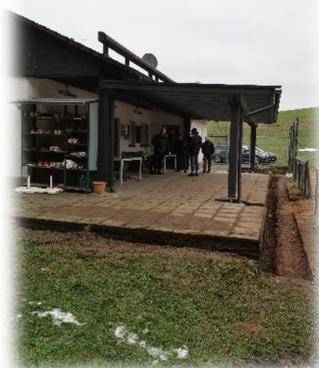
Fundamentgräben für die neue 22 Meter Mauer wurden ausgehoben.
